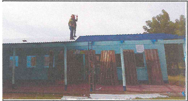
Foto 2: instalacion de lamina troquelada
