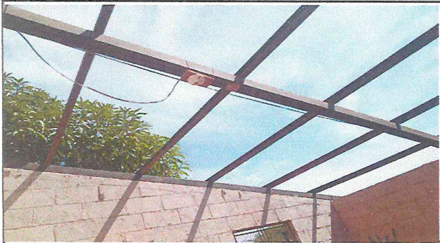
Foto 1: Mantenimiento de estructura metalica
